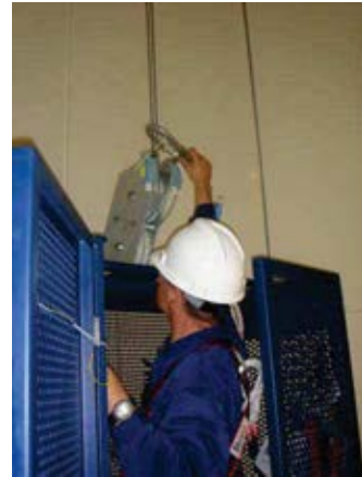
Accrocher le mousqueton à un point d'ancrage sécurisé.
