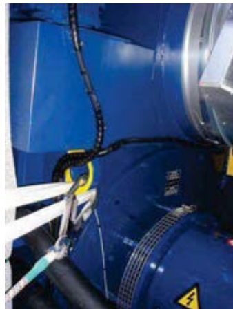
S'attacher en revêtant l'équipement antichute et en le fixant à un point d'ancrage prévu à cet effet à proximité de la sortie de secours.
