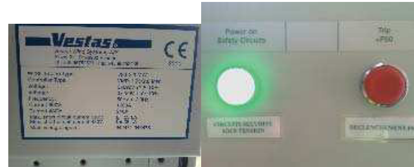
Figure 2.1.4: “Circuits sécurité sous tension”, “Déclenchement F60”, « Rating Plate » (item 144299) Place the sign on the ground controller
