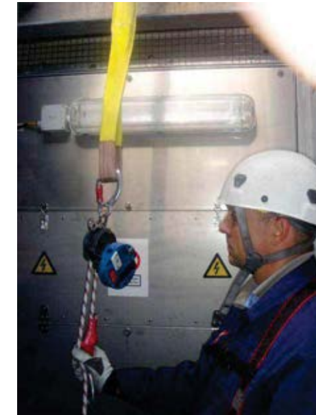
Accrocher le dispositif de descente d'urgence à un point d'ancrage prévu à cet effet.
